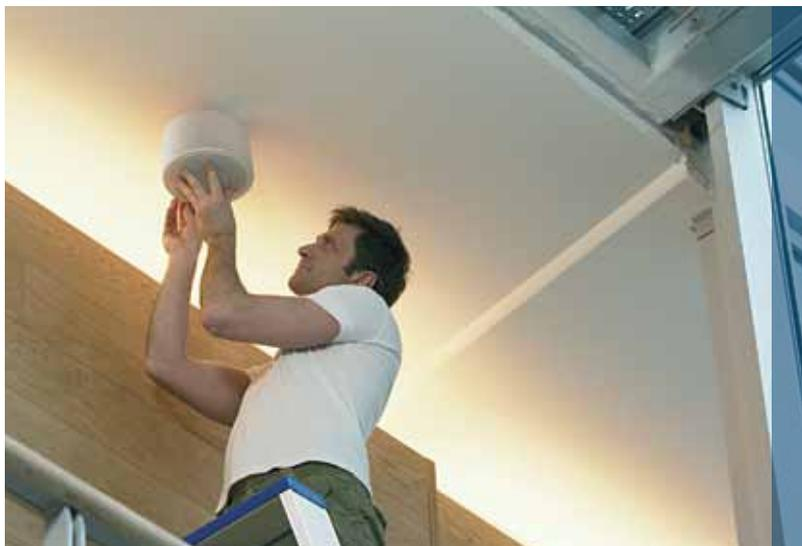
表面の硬い天井など、スピーカーのフラッシュ マウントが不可能な場所では、スタイリッシュな表面取り付けボックスを使えば、設置が簡単で見た目もすっきりします。
