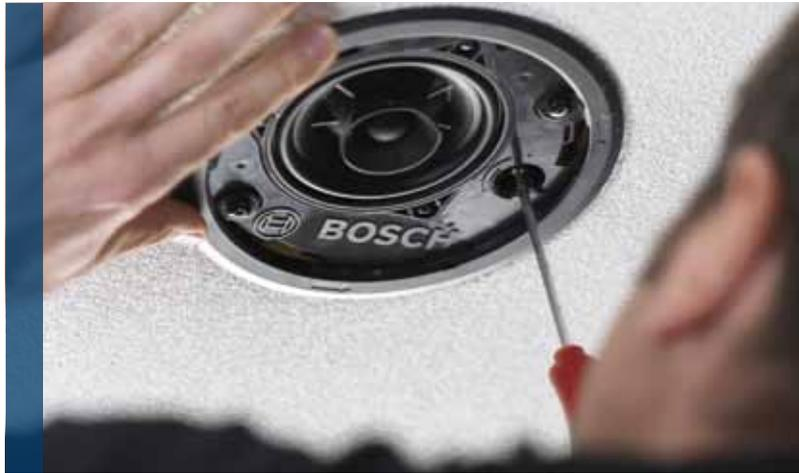
Mit dem Drehschalter zur Leistungsanpassung können Sie die Ausgangsleistung ändern, nachdem der Lautsprecher montiert wurde.
