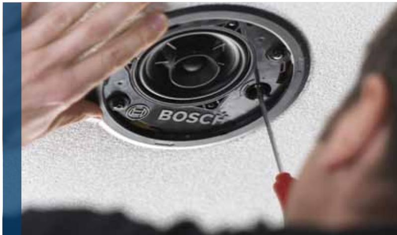
El interruptor de la toma permite cambiar la salida de alimentación una vez montados los altavoces.
