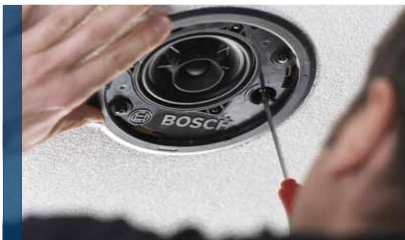
L'apposito selettore consente di modificare la potenza di uscita dopo il montaggio dell'altoparlante.
