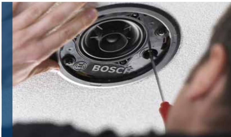
Переключатель мощности позволяет регулировать выходную мощность после установки громкоговорителя.
