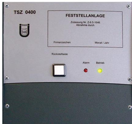
Die Türsteuerzentrale TSZ 0400 steuert in Verbindung mit angeschalteten Brandmeldern im Brandfall das Auslösen von 24 V-Feststelleinrichtungen wie Feuerschutztüren, Rauchklappen etc. sowie Signaleinrichtungen.
